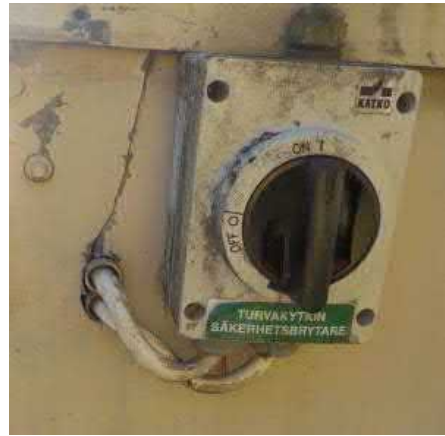
IV-koneen läpiviennit vesikatolla
