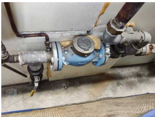
Ikääntynyt päävesimittari
