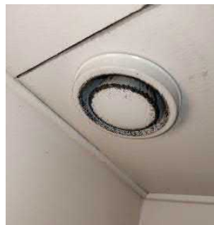
Likaantunut poistoilmaventtiili
