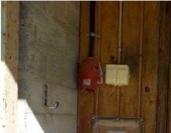
Varavoiman kytkentäpiste sisäänkäynnin luona
