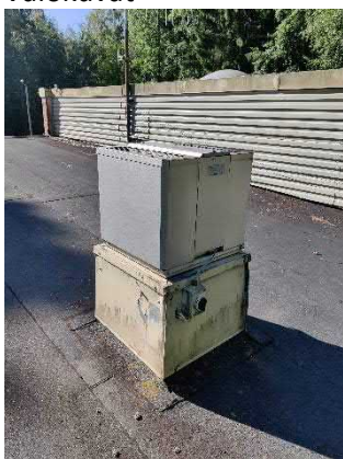
Poistoilmapuhallin
