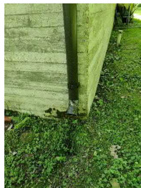
Hulevedet valuvat rakennuksen vierustalle
