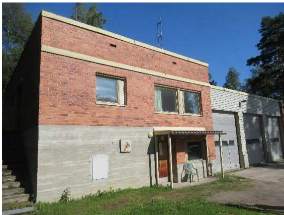
Yleiskuva etupihan julkisivusta (kaakkoon)
