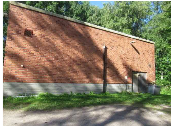
Yleiskuva päätyjulkisivusta (koilliseen)
