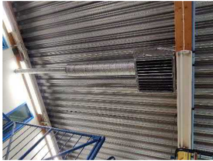
Poistoilmahuuhtimelle katonlävistävä kanava
