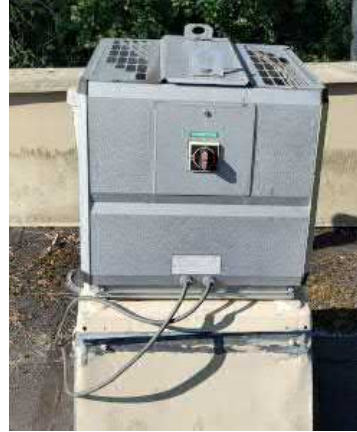
Huippuimurin sähköistystä vesikatolla
