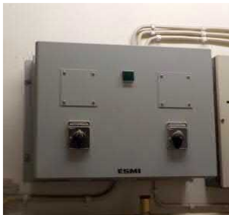
Turvavalokeskus lämmönjakohuoneessa
