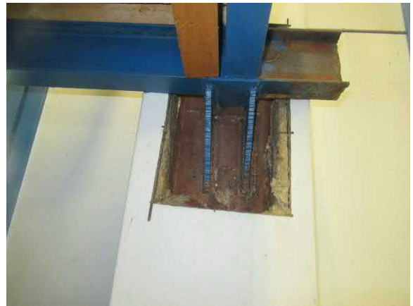
Autohallin pilari, johon kiinnitetty palkkeja
