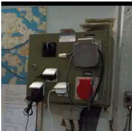
Pistorasiakeskus kalustohallissa
